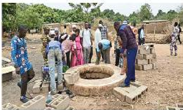
Figure 7. Entretien d'un puits villageois
